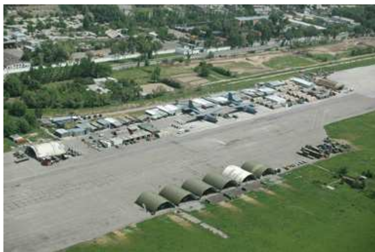
Survol des installations du DETAIR Douchanbé, à l'extrémité de la zone aéroportuaire
