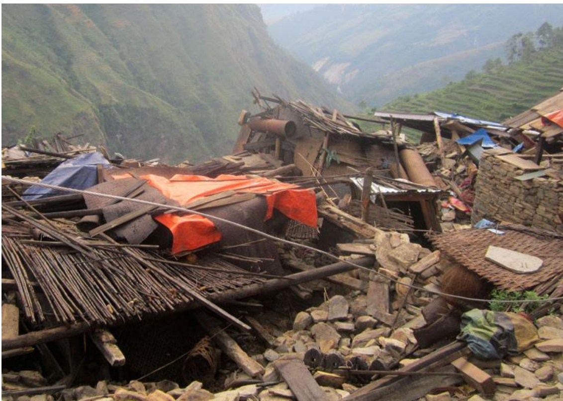
Fig. 9. Destructions dans le village de guides et de porteurs de Laprak (district de Gorkha), lieu de l'épicentre du séisme du 25 avril 2015 - ©Sunar Gurung
