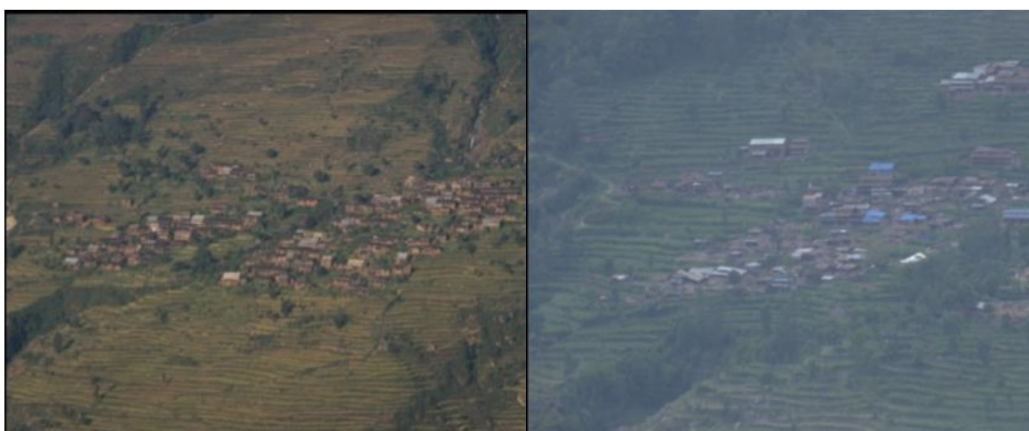
Fig. 3. Salmé avant et après le séisme du 25 avril © B. Ripert, © D. Blamont
