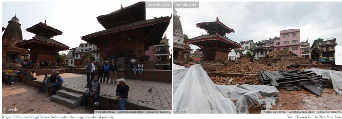
Fig. 3. Vue de la place Durbar de Patan avant et après le séisme du 25 avril. © New York Times sur images Google Views, 28 avril 2015.
