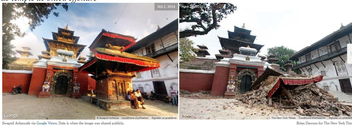
Le petit temple au-devant du Temple de Taleju, effondré
