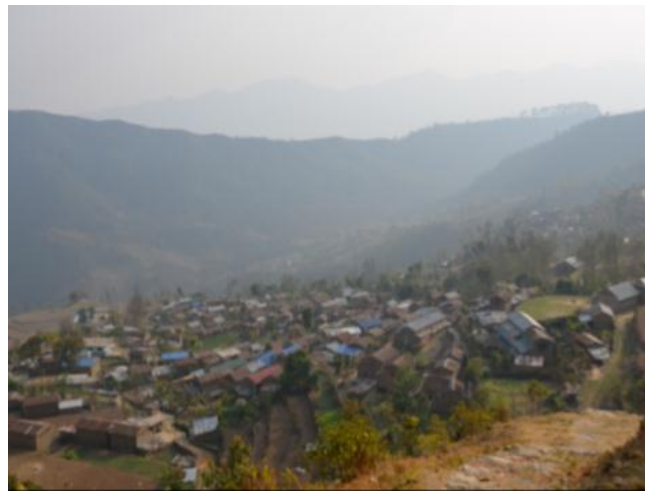
Fig. 4. Toitures en tôle du village de Bumtang © B. Ripert
