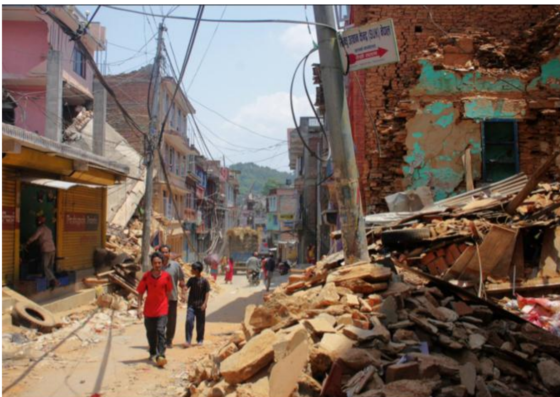
Fig. 4. Chautara, Sindhupalchok, après le séisme. ©IOM 2015.
