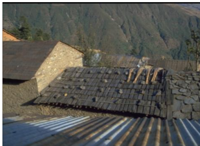
Fig. 5. Variété des matériaux utilisés pour les toitures à Salmé © B. Ripert
