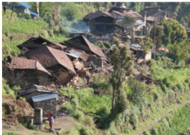
Fig. 12. L'écroulement des maisons les unes sur les autres à Salmé (© D. Blamont)
