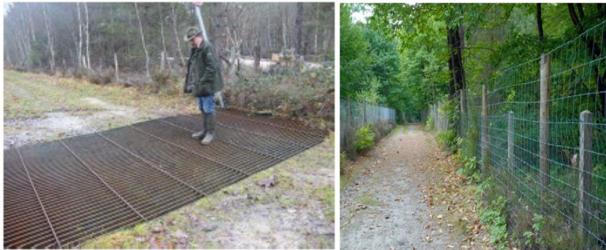
Grilles canadiennes et chemin entièrement grillagé en pleine nature
