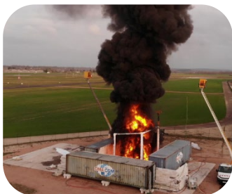
Incendie dû à des batteries au lithium
