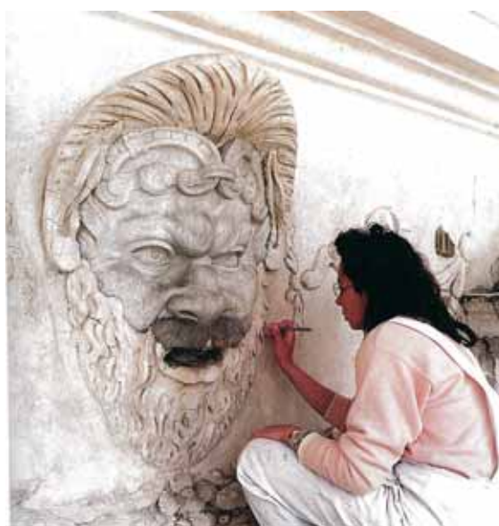
Masque de théâtre, en cours de restauration, corps central de la façade sur jardin de la Villa Médicis à Rome. Achèvement du nettoyage. Ph. SEI.
