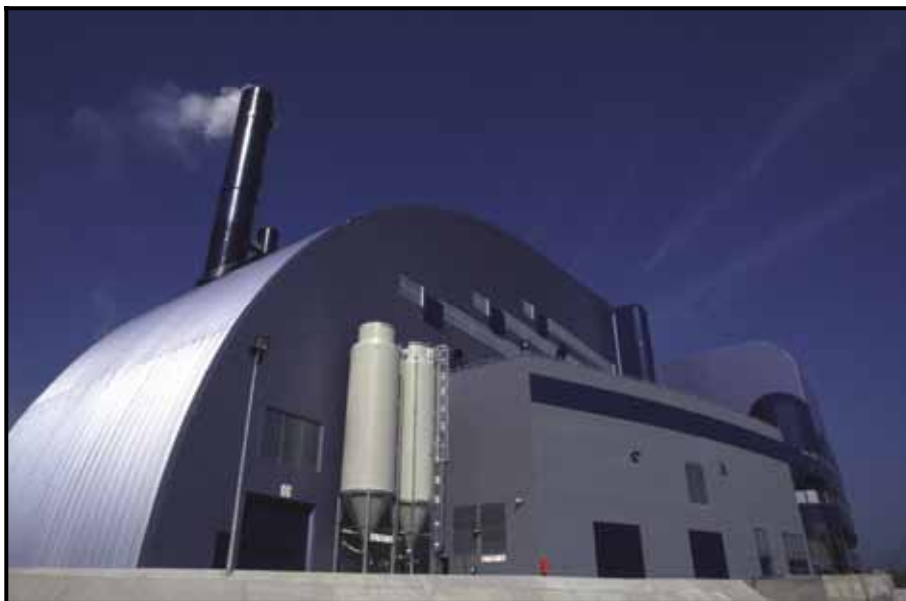
Usine d'incinération de Bellegarde (Ain)
