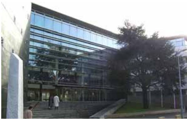
Les locaux du service central d'état civil, à Nantes
