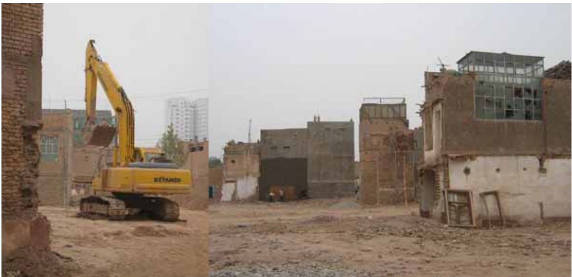
Quartier Nord-Ouest de la cité ouïghoure en cours de destruction (Aout 2010)
