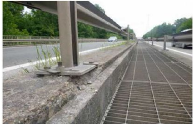
Illustration 6: Caillebotis en TPC, fixation de la glissière sur corniche
